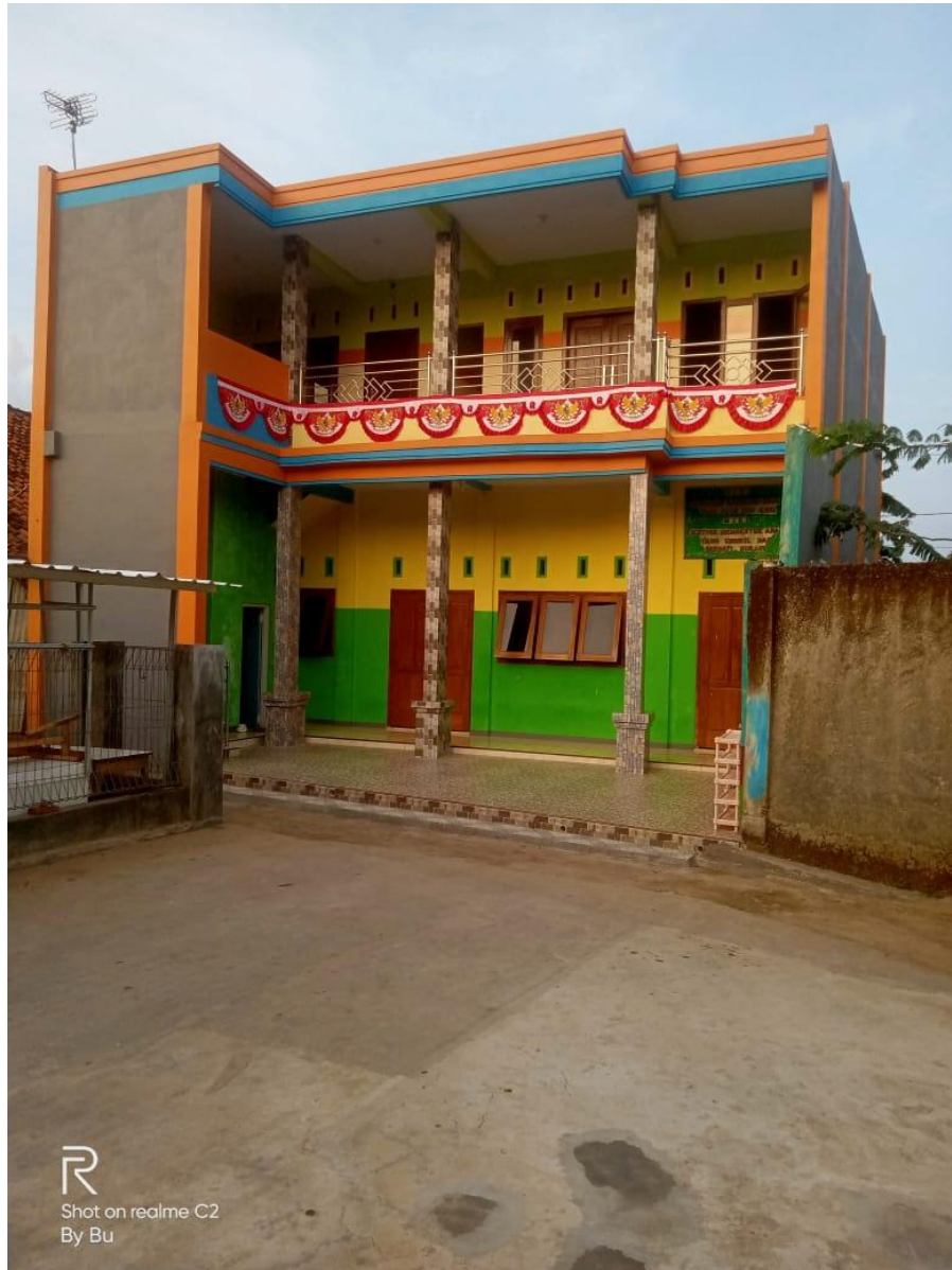
Gambar 1 Gedung RA Al Khufadz Pegiringan Kecamatan Bantarbolang Kabupaten Pemalang
